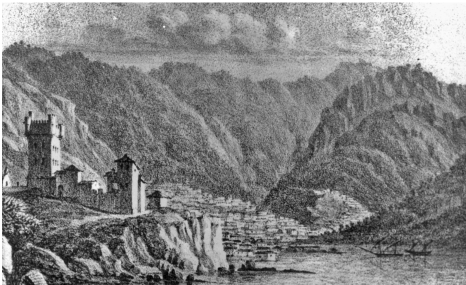
Ο πύργος των Κιτριών. Χτίστηκε από τον Τζανέτμπεη Κουτούφαρη και έγινε έδρα του εκάστοτε μπέη της Μάνης
